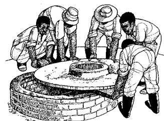
Posez le couvercle de puits durci en place.
