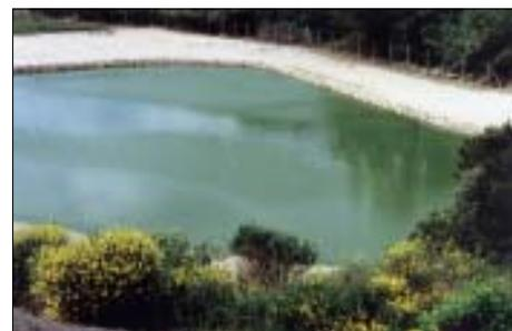
*Lagunage dans l'Hérault : certains systèmes se bornent à mettre en œuvre l'épuration par algues unicellulaires.*
